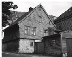
Bilde: Peter Motzfeldts gate 3 så den fremfor i 1957. Bygningen står i hovedsak uendret utvendig, bruket dog blant annet til kaffe (2000-2005), kontor (2006, 2007-2008)
